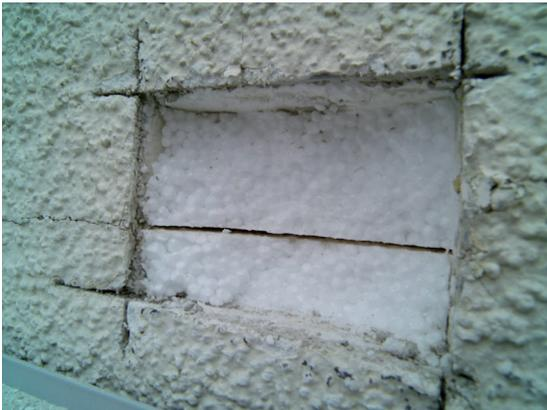
Abb. 9: Riss als Folge nicht-dichtgestoßener Dämmplatten
