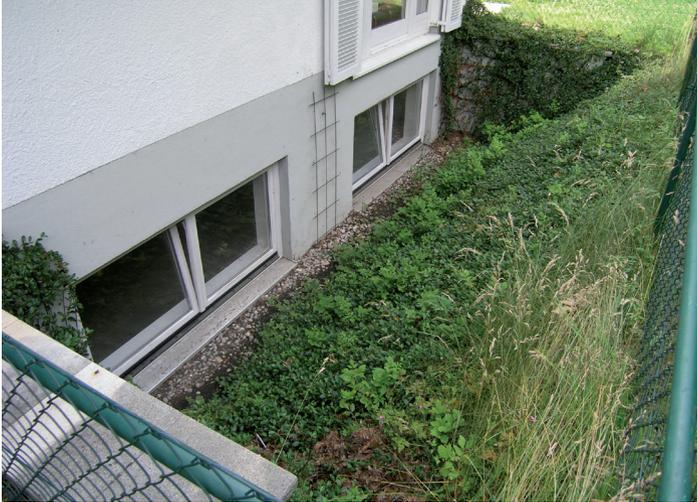
Abb. 13: Fehlerquelle falsch entwässerter Lichtgraben
