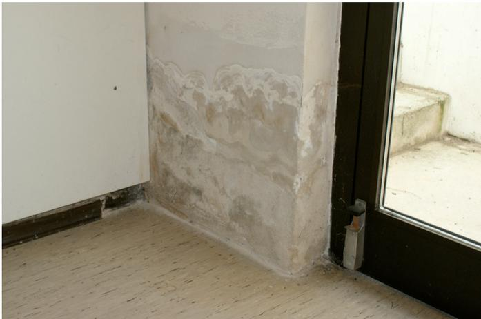
Abb. 12: Massive Schäden durch Wasser im Untergeschoss
