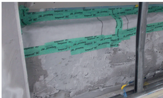
Abb 282: Geöffnete Wand nach Sanierung. Die Fußpfette wurde verkleidet und die Dampfbremse wurde mittels Klebewulst und zusätzlich mittels Klebebändern befestigt. Der Verputz der Drempelwand wurde vervollständigt.
