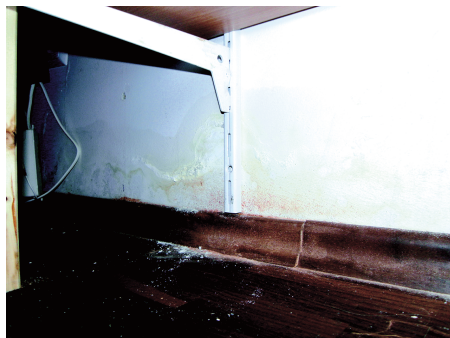
Abb 302: Schimmelschäden in der Speisekammer Abb 303: Wasserschaden
