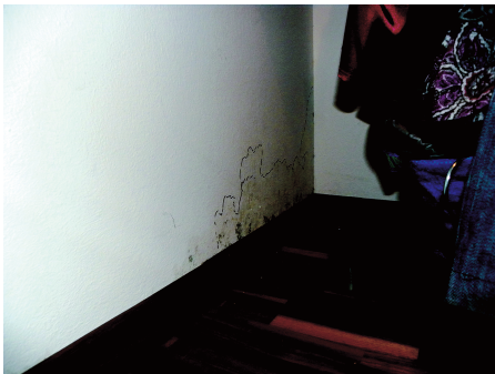
Abb 300: Wasserschaden
