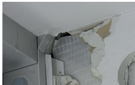
Abb 284: Nicht angeschlossene Dampfbremse
