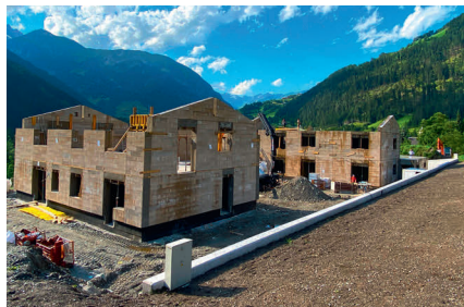
Abb. 13 + 14: Kondensatschäden können beim Holzspanstein mit Innendämmung baupraktisch nicht entstehen. Die raumseitige Oberfläche ist wasseraufnahmefähig, also „sorptiv“, und sie speichert Wärme. Bildquelle: ISO SPAN Baustoffwerk GmbH, isospan.eu
